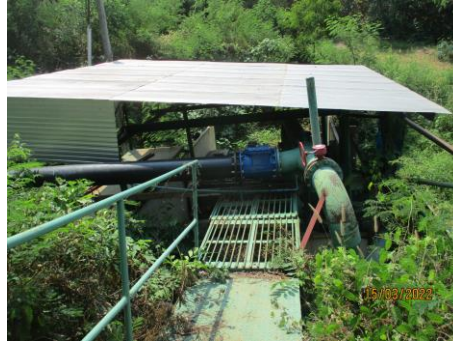
รูปที่ 19 จุดสูบน้ำจากแม่น้ำแควของโครงการ
