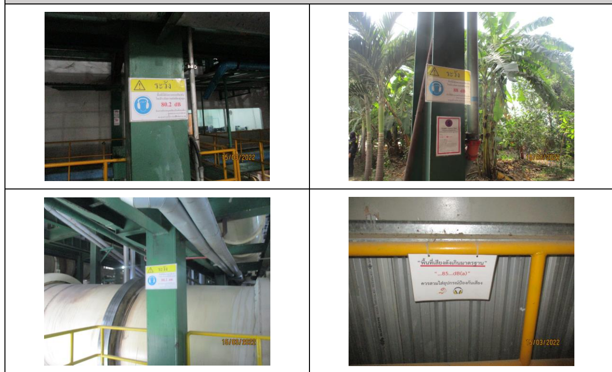
รูปที่ 16 ป้ายเตือนพื้นที่ที่มีเสียงดังเกิน 85 เดซิเบล (เอ)
